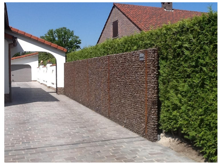
Schanskorf met lavastenen 2 m H. gesteund door gegalvaniseerde palen. Rondom airco units een thuja haag
